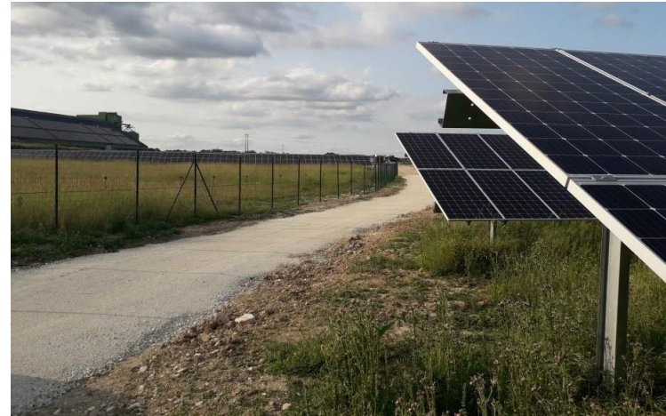
Clôture mise en place – ferme solaire en construction par IEL (Source : Etude d'impacts)
